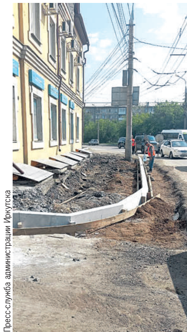
Одновременно с новым дорожным покрытием обустраиваются тротуары.
