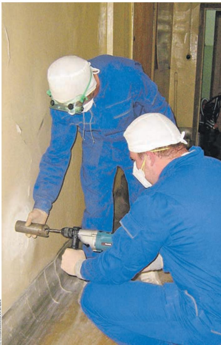
Вчера 14:00 Дезактиваторы в полном комплекте индивидуальной защиты срезают инженерные коммуникации и верхний слой штукатурки — там остались следы плутония и «осколочных» элементов
