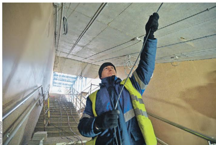
Вчера 10:08 Электромонтажник Иван Панкратов протягивает кабель во время строительных работ на станции «Минская» МЦД-4
