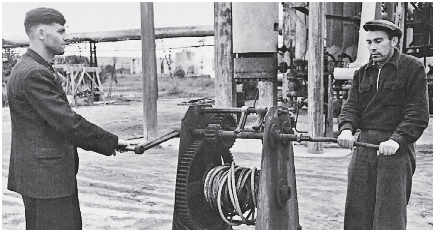
В годы войны Московский НПЗ продолжал работать, несмотря на бомбежки. Бывший цех № 3. Установка алкилирования бензола
